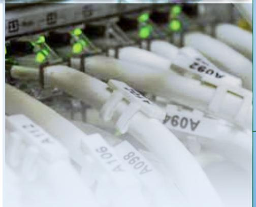
Цельные бирки **MG2-TDMO** не требуют применения прозрачных держателей и закрепляются на кабелях с помощью двух отверстий, рассчитанных на определенный диапазон размеров кабелей.
