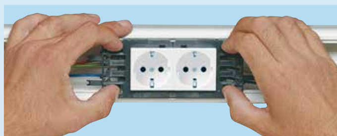
Монтаж розеток Mosaic в кабель-каналы DLP
