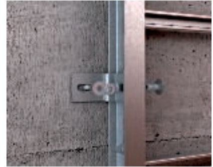
Крепление вертикального кабельного лотка лестничного типа промышленного исполнения Настенное крепление вертикального кабельного лотка лестничного типа промышленного исполнения осуществляется с помощью крепежных уголков BW80/55.
