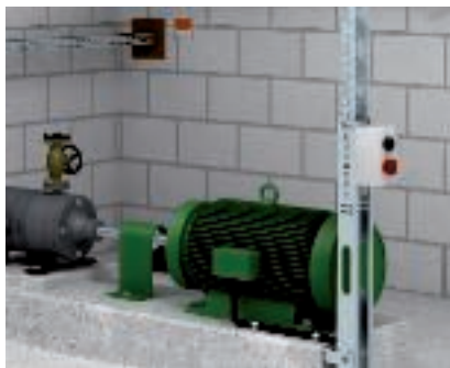
Стойка подвода питания к электрооборудованию Соединение электроприводов со стойкой для подвода питания.
