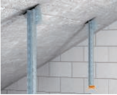
Регулируемая траверса с профилем US 3 Монтаж регулируемой траверсы KU 3 V на профиле US 3.
