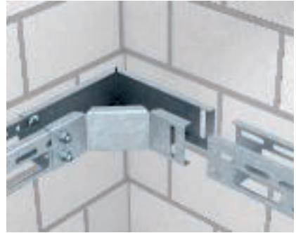
Установка фасонной детали кабельного лотка для монтажа светильников Монтаж фасонных деталей кабельных лотков для монтажа светильников.
