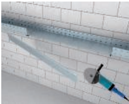
T-образное ответвление с помощью угловой секции Извлечение боковой стенки из кабельного лотка для больших расстояний.
