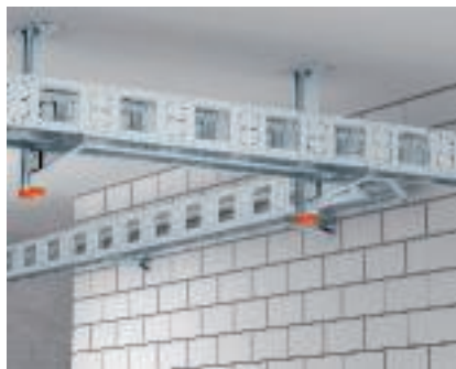
Монтаж кабельных каналов ВКК Монтаж системы кабельных каналов ВКК под потолком с помощью стоек IS 8.
