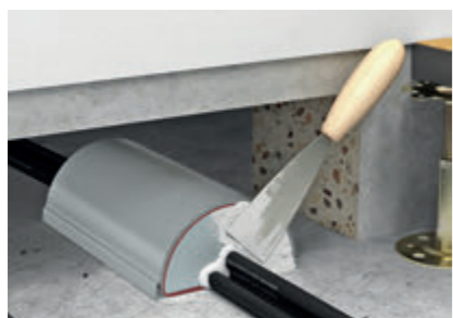
Шпатлевание поверхностей для предотвращения проникновения дыма защитным покрытием ASX.
