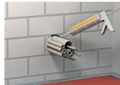
Заполнение кольцевого зазора вспенивающимся огнестойким защитным средством DSX.
