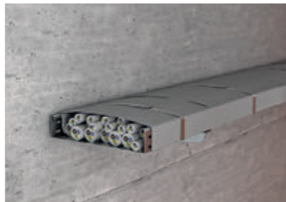
Полное бандажирование кабеля в кабельном лотке при настенном монтаже трассы.
