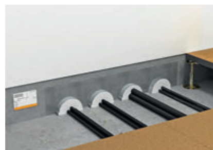
Установленная проходка в комбинации с огнестойким раствором PYROMIX®.
