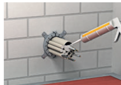
Заполнение концов труб огнестойким защитным средством DSX.
