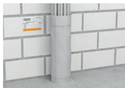
Закрепление оставшегося отверстия проходки шпатлевкой и монтаж идентификационной таблички.
