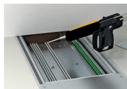
Нанесение огнестойкой пены непосредственно под стену.
