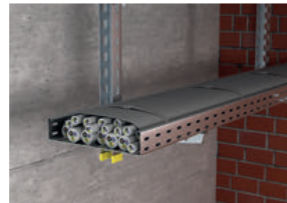
Бандажирование кабельного пучка на несущих системах.
