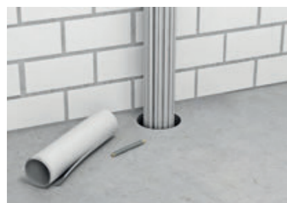
Подготовка кабельной проходки.
