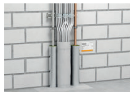
Установка огнестойкого бандаж с нулевым зазором для проходки Rockwool Conlit для труб.
