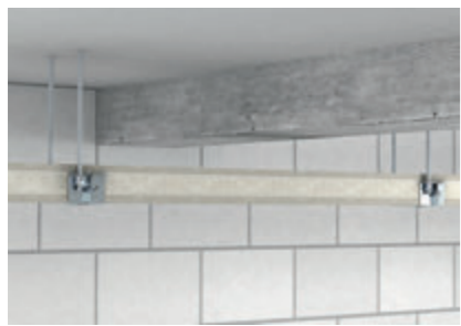
Подвесной монтаж на соединительных элементах.
