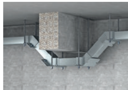
Потолочный монтаж с вертикальными угловыми секциями.
