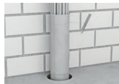
Фиксация бандаж с помощью проволоки.
