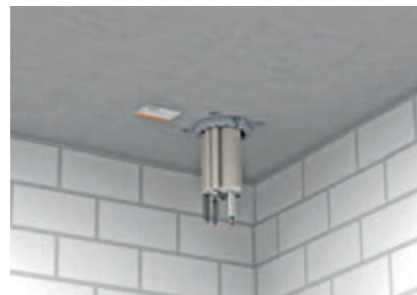
Монтаж на нижней стороне перекрытия с помощью металлических дюбелей.
